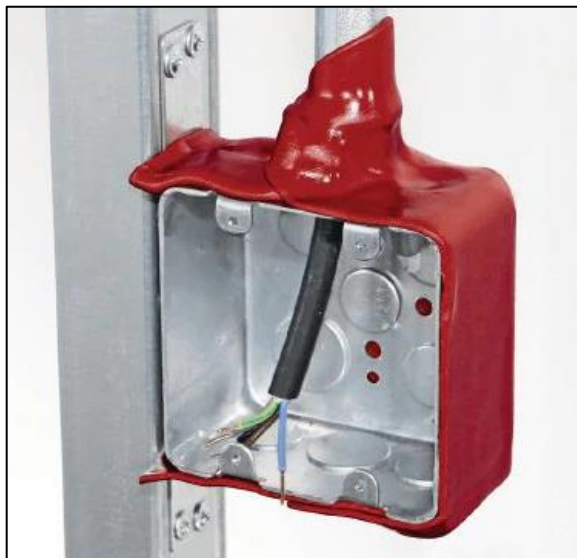
Figura 3.2: Ejemplo de instalación de masilla cortafuego en caja eléctrica
